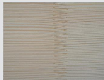
Плотное примыкание при срачивании на минишип в 10 мм
