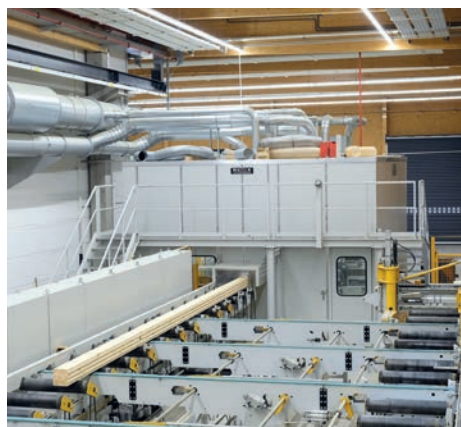
In der neuen Fertighobelhalle der Hördener Holzwerke
