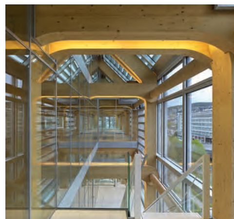
Das Tamedia Mediengebäude in Zürich ist der erste siebengeschossige Holzbau in der Schweiz. Die Fa. Blumer Lehmann Holzbau fertigte die Bauteile auf Krüsi Maschinen und mit LEUCO Werkzeugen.
