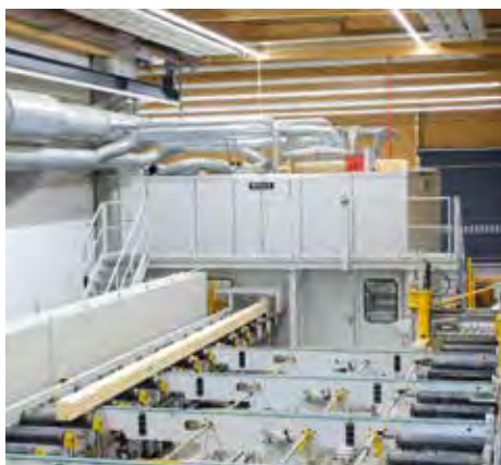
In der neuen Fertighobelhalle der Hördener Holzwerke.
